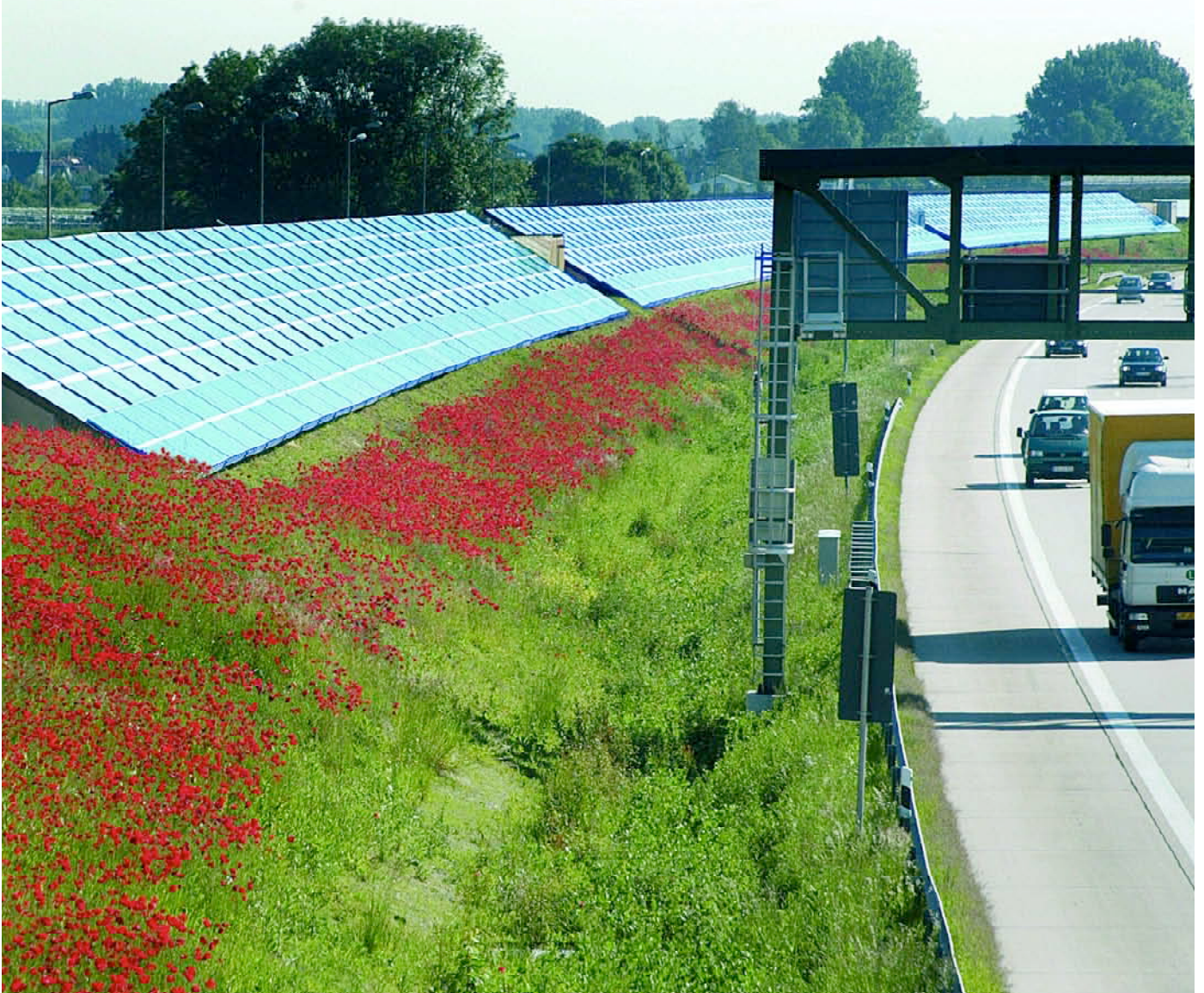
Intelligente Doppelnutzung: Photovoltaikanlage und Schallschutzwand in einem System. Die Anlage mit 500 kWp wird von den Stadtwerken Freising betrieben. Foto: Freisinger Stadtwerke Versorgungs-GmbH
